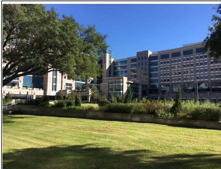
Mays Clinic以及 Duncan building全 景。
